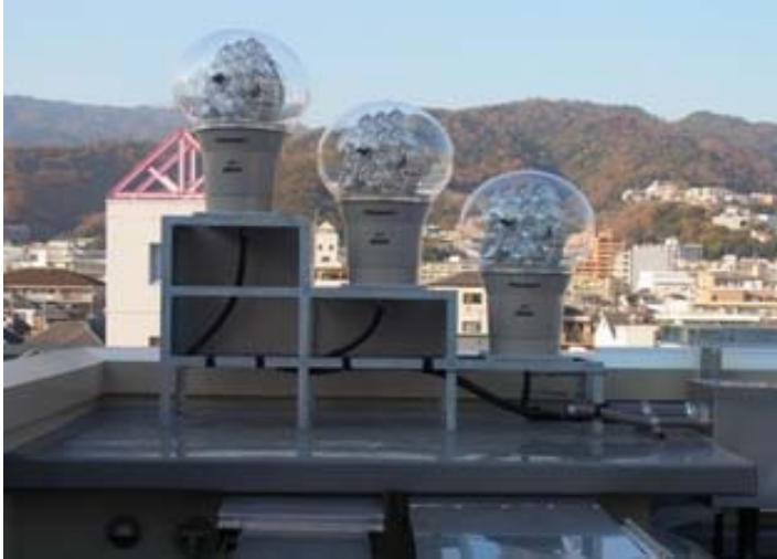
(店舗屋上に設置 12眼ひまわり)
