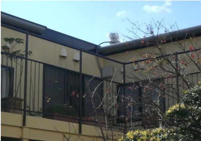
【2F 屋上に設置】
