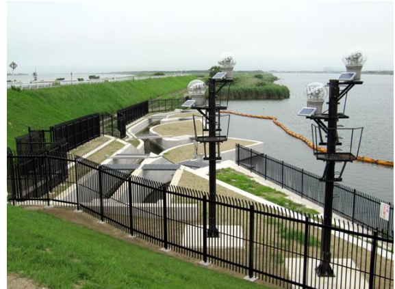
常陸利根川水門魚道
