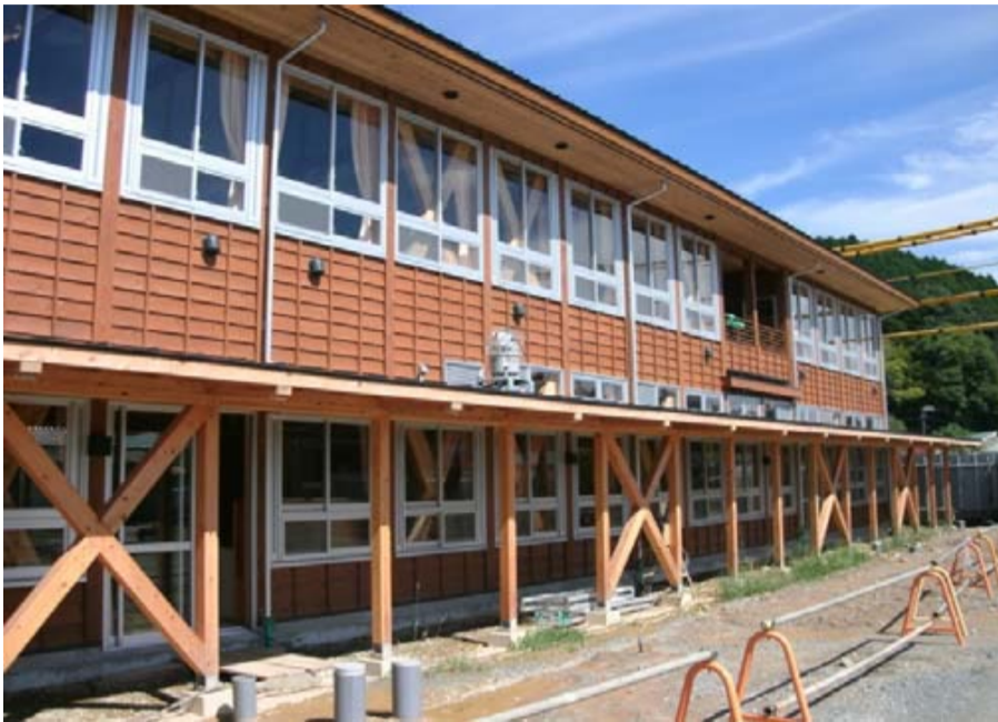
【集光機：新校舎南側1F底上に設置】
