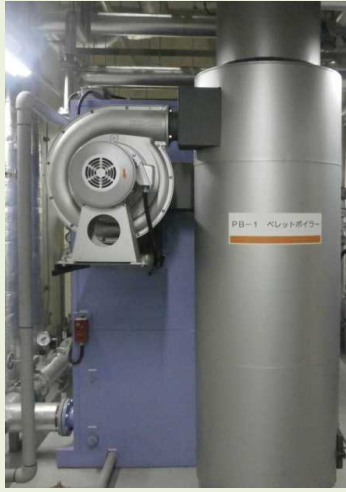
ペレットボイラー設備を校舎棟に整備し、概要図を校内に掲示 (北海道札幌市 市立札幌開成中等教育学校)
