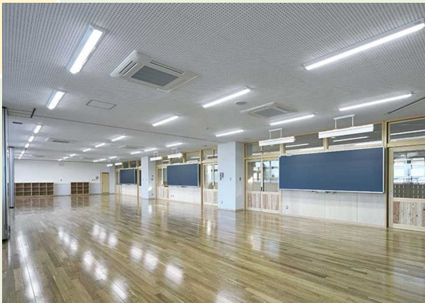
LED照明の設置 (栃木県栃木市立大平南小学校)
