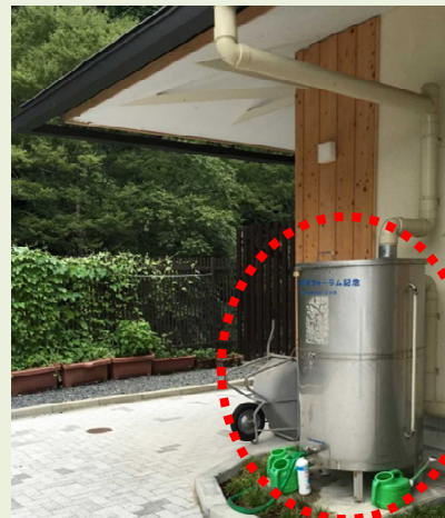
雨水タンクを設置し、プランターの水やりに活用 (京都府京都市立八瀬小学校)
