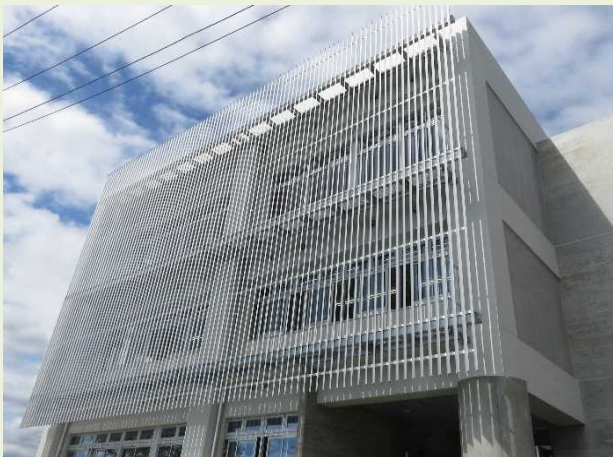
太陽光の入射角が制限され室温上昇を抑制するルーバーの設置 (神奈川県南足柄市立福沢小学校)
