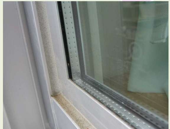
複層ガラスの設置 (新潟県長岡市立新町小学校)
