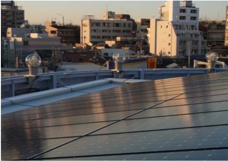
(店舗屋上より 12眼ひまわり)
