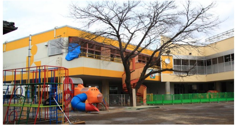
【改修工事中の園庭】
