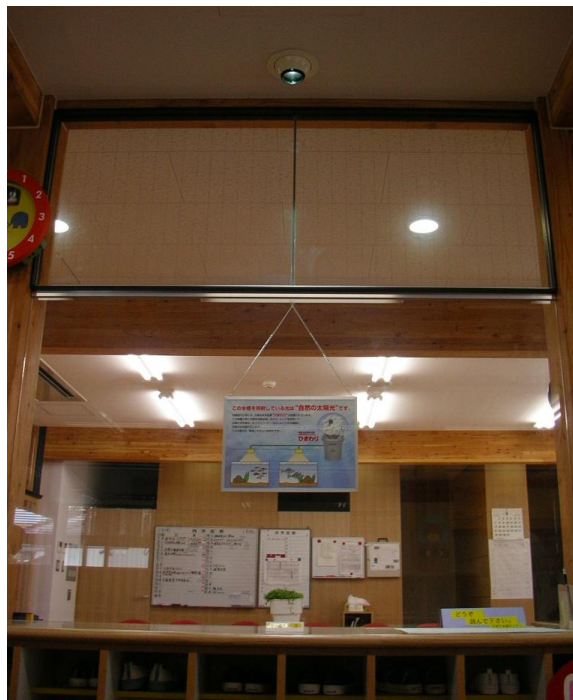
【玄関ホールへの照射】
